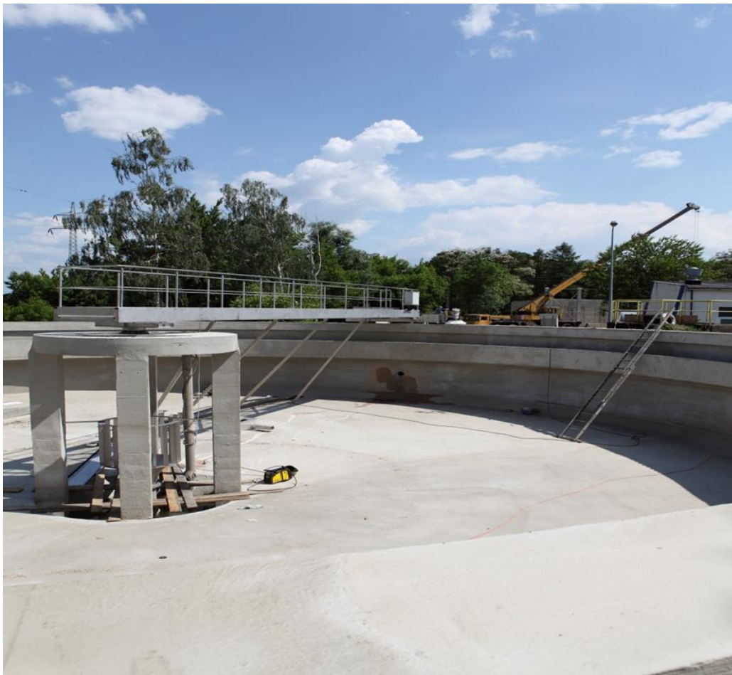
Piaskownik - Miejska Oczyszczalnia Ścieków w Sochaczewie
